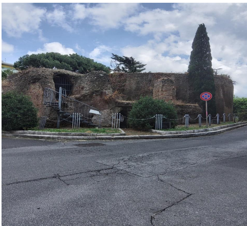
Cisterna. Via Cristoforo Colombo
