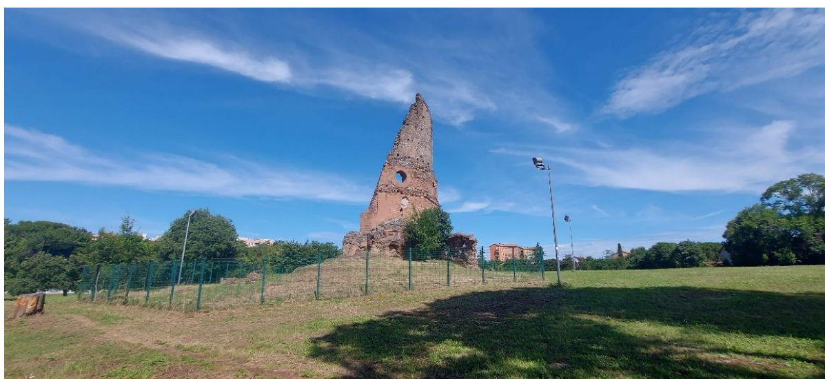
Cisterna Grande di Via Prenestina
