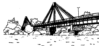
Ponte canale impianto di depurazione Roma nord 1980 d.C.
